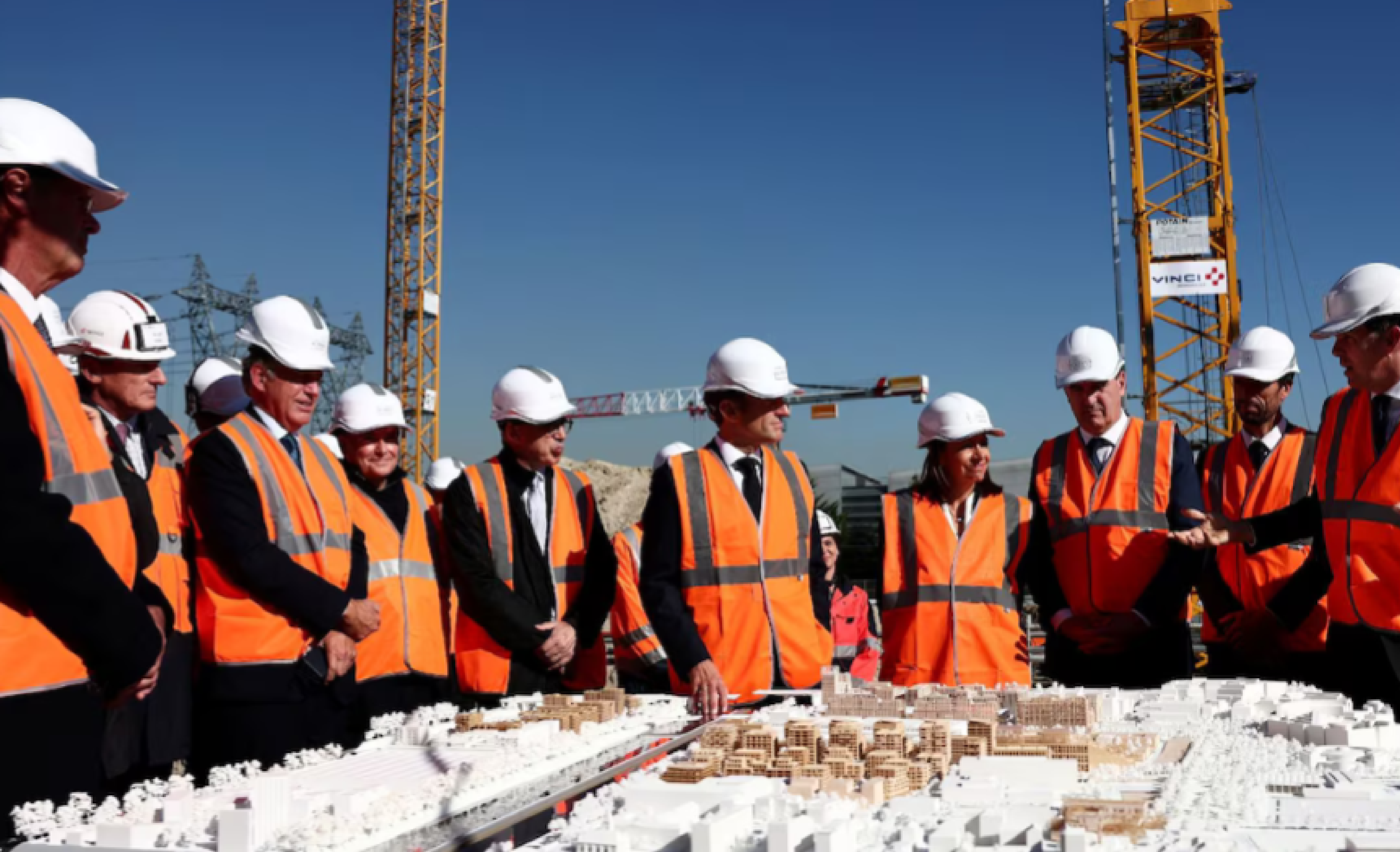
Photo de Sarah MEYSSONNIER (afp). Visite du chantier du Village Olympique avec Emmanuel Macron, Jean Castex, Anne Hidalgo. Octobre 2021, Saint-Denis.
